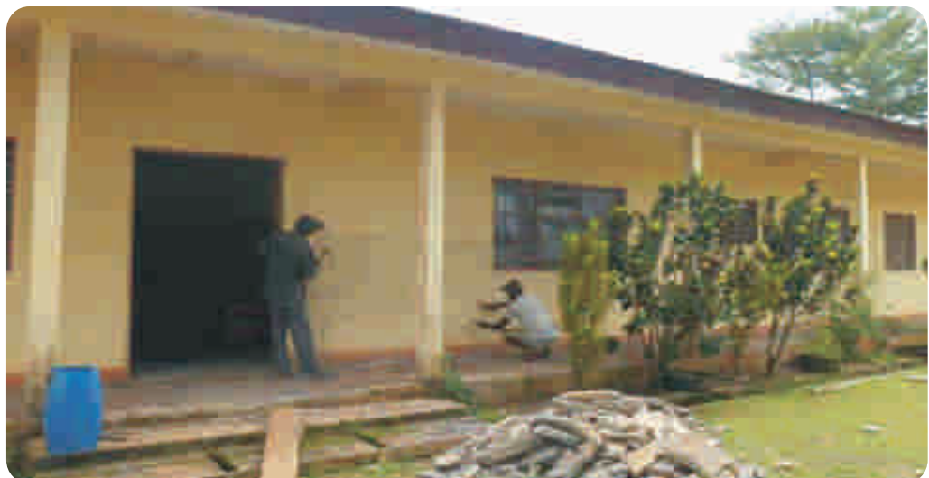
Obras de rehabilitación Hospital de Monavebe.
