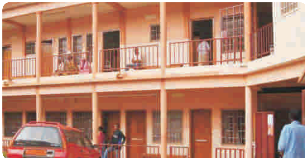
Exterior del Centro Hospitalario Dominicano Saint Martin de Porres - Yaundé.
